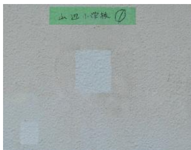
写真 10. コアを抜き取った箇所の修復
