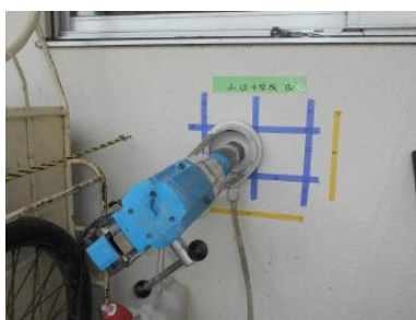
写真 8. コアの抜き取り
