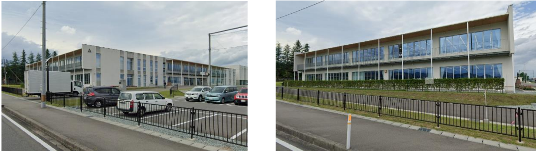
写真 3. 学校外観（山辺中学校）
