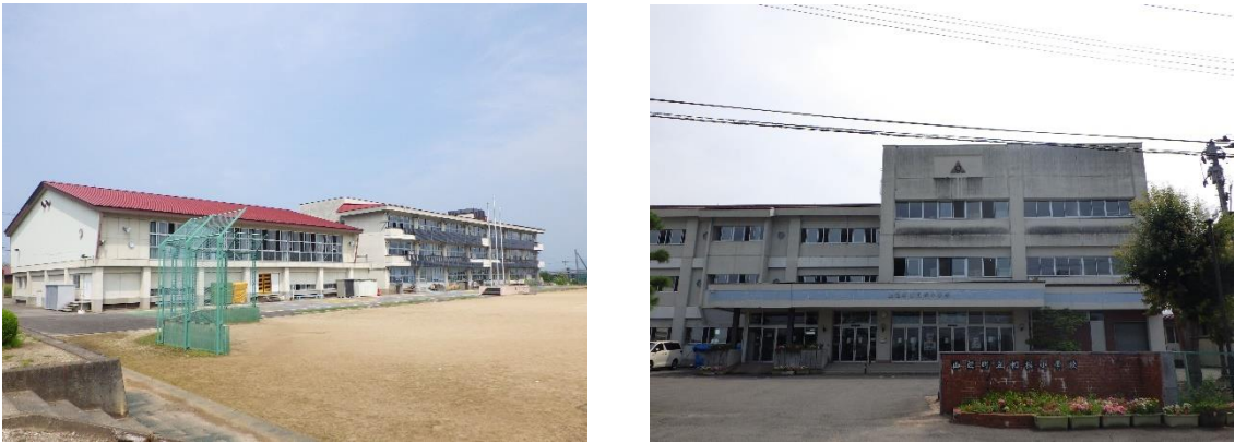
写真 2. 学校外観（相模小学校）
