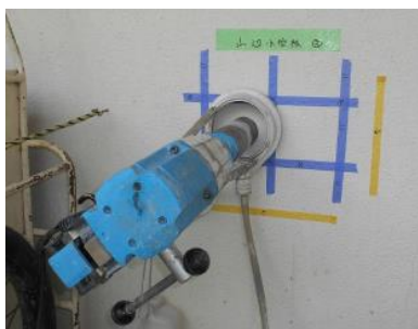
写真 4. コアの抜き取り
