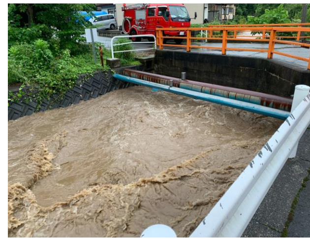
久保地内観音橋
