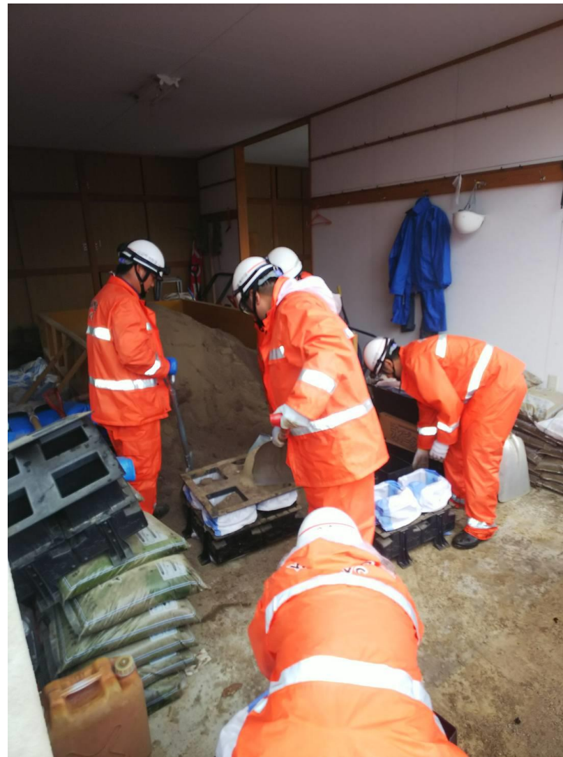
水防倉庫内土のう作成
