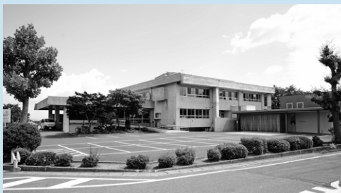
北側駐車場の修繕を行う中央公民館
