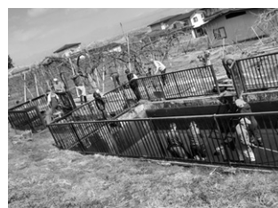
大寺上道地区にある大型水槽と泥吐き水槽(上流)
