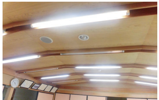
LEDに交換されていない蛍光灯
