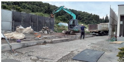
解体作業中の空き家
