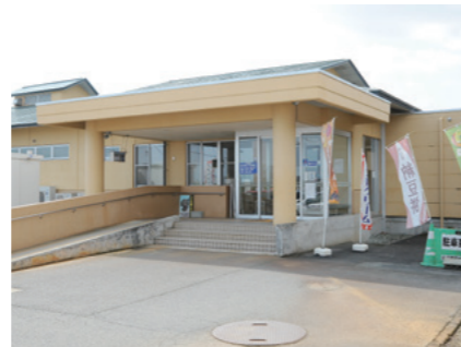
内装工事が待たれる山辺温泉
