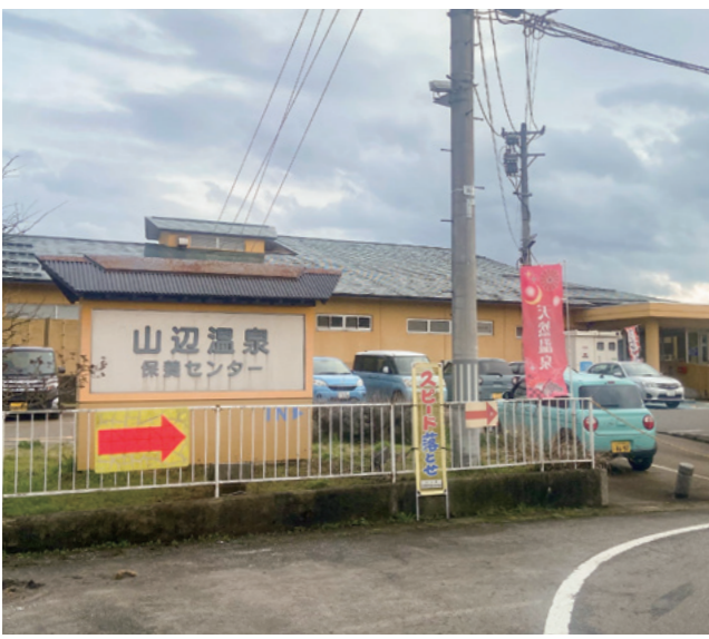
内装工事をする山辺温泉
