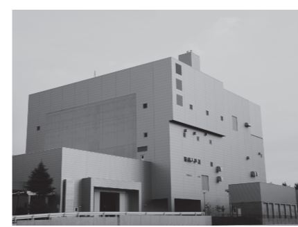
エネルギー回収施設 (上山市)
