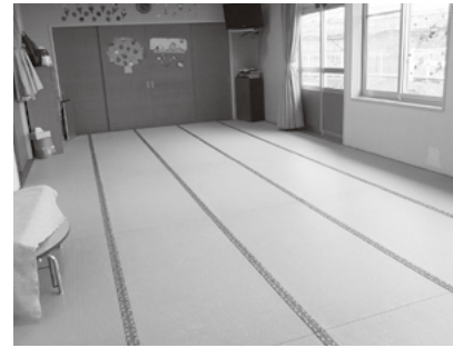
子育て支援センター空調設備・抗菌床への改修
