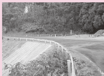
除雪路線の確保のため復旧工事が進む町道中作線
