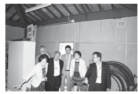
1号源泉ポンプの確認
