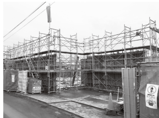
建設中の「ウイングガーデン山辺」
